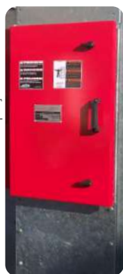
Janela de Inspeção
